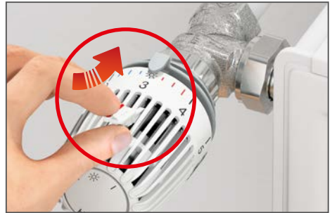
Abb. 6: Sparclip einsetzen
